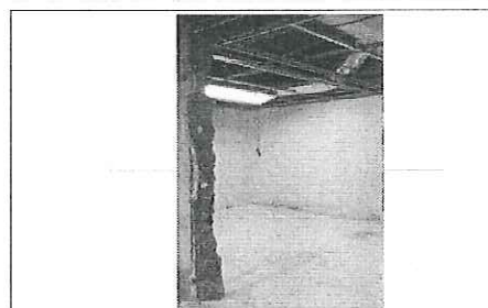
FOTO No. 8: DEMOLICION DE PLAFON HGZ 33 FOTOGRAFIA FUE TOMADA EL DIA 05 DE SEPTIEMBRE 2023.
