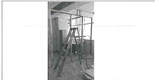
FOTO No. 4: DEMOLICION DE MUROS DE TABLAROCA UMF30 ESTA FOTOGRAFIA FUE TOMADA EL DIA 08 DE SEPTIEMBRE 2023.
