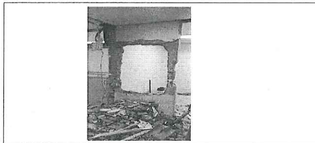
FOTO No. 7: DEMOLICION DE MUROS HGZ 33 ESTA FOTOGRAFIA FUE TOMADA EL DIA 04 DE SEPTIEMBRE 2023.
