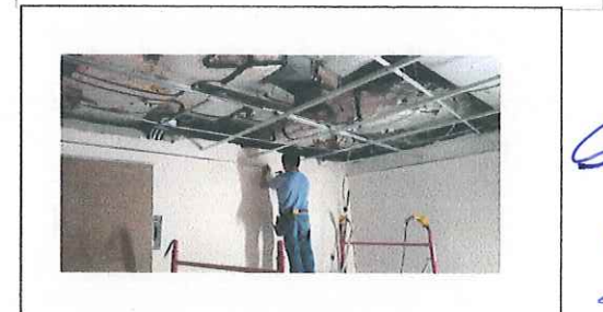
FOTO No. 9: COLOCACION DE SOPORTERIA PLAFONHGZ 33 ESTA FOTOGRAFIA FUE TOMADA EL DIA 28 DE SEPTIEMBRE 2023
