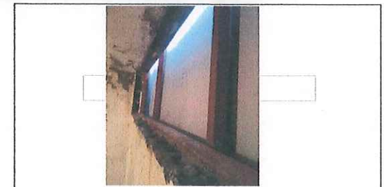
FOTO No. 3 RETIRO HERRERIA HGZ 4 FOTOGRAFIA TOMADA EL DIA 29 DE SEPTIEMBRE 2023
