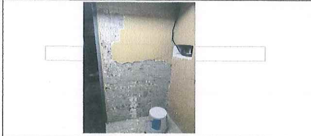
FOTO No. 1: DEMOLICION DE CINTILLA HGZ 4 FOTOGRAFIA TOMADA EL DIA 28 DE SEPTIEMBRE 2023
