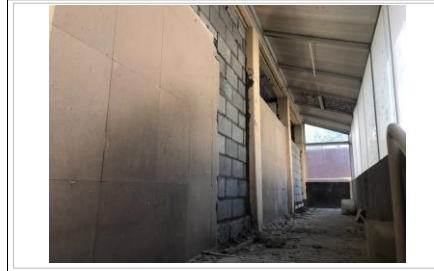
FOTO No. 2: TRABAJOS DE CIERRE DE ACCESO EN AREA DE VESTIDORES.
