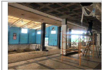
FOTO No. 8: TRABAJOS DE CANALIZACION ELECTRICA.
