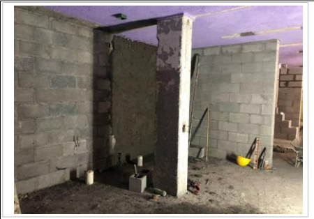
FOTO No. 4: TRABAJOS DE REPELLADO EN DESPLANTE DE MUROS PARA LA SECCION DE VESTIDORES
