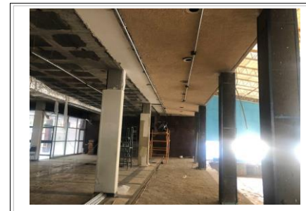
FOTO No. 9: TRABAJOS DE CANALIZACION ELECTRICA, CERRADAS AL 100%
