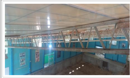
FOTO No. 1: VISTA SUPERIOR DE LA TECHUMBRE ACTUAL PARA EMPEZAR LA LOGISTICA DEL MANTENIMIENTO.
