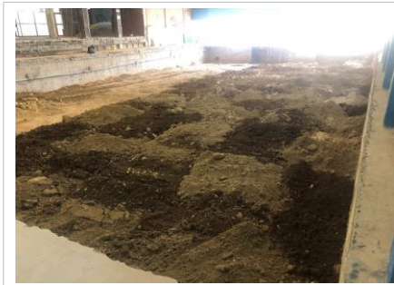
FOTO No. 5: TRABAJOS DE DISPERSION DE MATERIAL PARA EMPEZAR LOS TRABAJOS DE COMPACTACION.
