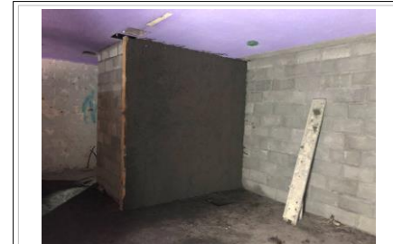
FOTO No. 3 TRABAJOS DE REPELLADO EN DESPLANTE DE MUROS PARA LA SECCION DE VESTIDORES
