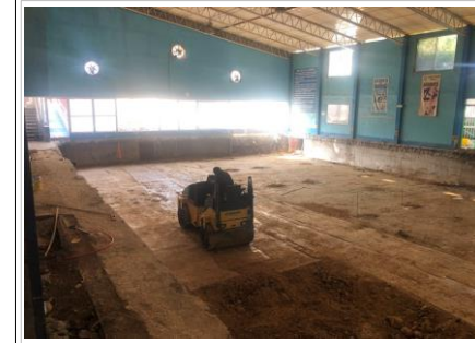
FOTO No. 6: TRABAJOS DE COMPACTACION EN AREA DE VASO DE ALBERCA.
