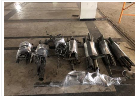
FOTO No. 5: TRABAJOS DE APILE Y EMBALAJE DE MATERIAL DE COBRE ENTREGADO AL AREA ADMINISTRATIVA DEL CSS1
