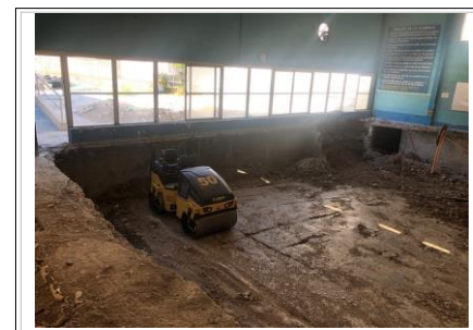
FOTO No. 9: TRABAJOS DE PREPARACION DE MEJORAMIENTO DEL FIRME DEL VASO DE ALBERCA.
