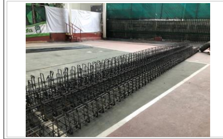
FOTO No. 2: SE TERMINAN LOS TRABAJOS DE LOS ARMADOS DE
