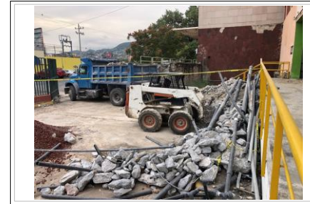
FOTO No. 3 AREA DE APILE, CARGA Y RETIRO DE ESCOMBRO, SECCION OTORGADA POR EL CSS1 PARA USAR DURANTE LA EJECUCION DEL PROYECTO.
