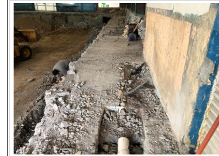
FOTO No. 6: TRABAJOS DE DEMOLICION DE AREA DE REGADERAS EXISTENTES Y PREPARACION PARA REGISTRO DE SANITARIO EN LA MISMA SECCION A REMODELAR.
