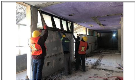
FOTO No. 7: TRABAJOS DE RETIROS DE CANCELERIA EXISTENTE
