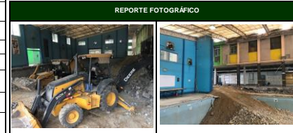
DEMOLICION DE VASO DE ALBERCA PREPARACION DE RAMPA PARA ACCESO DE MAQUINARIAS
