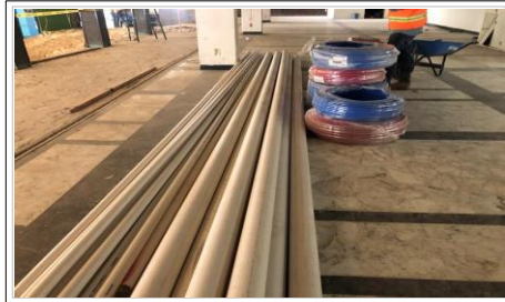
FOTO No. 1: LLEGADA DE MATERIAL HODROSANITARIO, RESGUARDADO EN EL AREA DE LA OFICINA SINDICAL EXISTENTE Y PRESTADA POR EL CSS1 PARA USAR DURANTE LA EJECUCION DEL PROYECTO.
