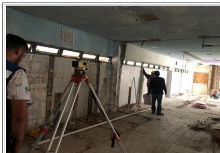
FOTO No. 8: TRABAJOS DE NIVELACION DE LOS FIRMES EN EL AREA DE LOS VESTIDORES, PARA DETERMINAR LOS TRABAJOS DE RANURAS Y COLOCACION DE SALIDAS HIDROSANITARIAS.
