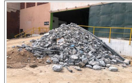
FOTO No. 3 AREA DE APILE, CARGA Y RETIRO DE ESCOMBRO , SECCION OTORGADA POR EL CSS1 PARA USAR DURANTE LA EJECUCION DEL PROYECTO.
