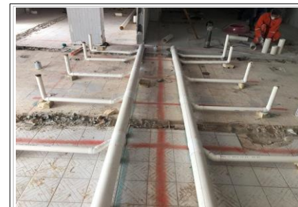
FOTO No. 9: TRABAJOS DE PPRESENTACION DE LA RED SANITARIA DEL AREA DE LAS REGADERAS.
