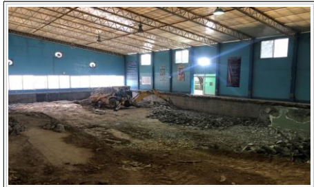
FOTO No. 7: TRABAJOS DE DEMOLICION Y RETIRO DE ESCOMBRO SOBRANTE DEL AREA DEL VASO DE LA ALBERCA, TRINCHERA ASI COMO EL RETIRO DE LAS INSTALACIONES EXISTENTES ALREDEDOR DE LA TRINCHERA.
