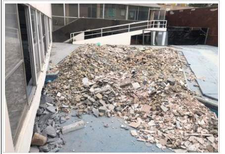
FOTO No. 4: TRABAJOS DE RELLENO DEL CHAPOTEADERO PARA TRABAJAR EL MEJORAMIENTO DE ESA AREA EXTERIOR .
