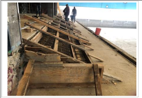
FOTO No. 4: TRABAJOS DE CIMBRADO DE ESCALONES DEL PASILLO PRINCIPAL AL AREA DE TRINCHERA DE ALBERCA.
