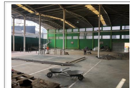
FOTO No. 9: TRABAJOS DE LIMPIEZA DE AREAS DE TRABAJOS.
