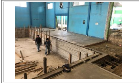
FOTO No. 1: DESCIMBRA DE AREA DE VASO DE ALBERCA Y TRINCHERA.
