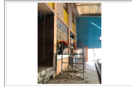
FOTO No. 3 TRABAJOS DE PREPARACION PARA RECIBIR ACABADOS EN AREA DE REGADERAS HACIA ALBERCA.
