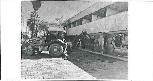
FOTO No. 1: FOTOGRAFIA TOMADA EL DIA 16 DE OCTUBRE 2023
