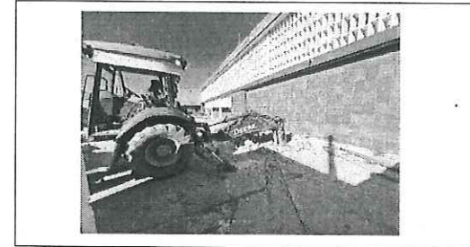
FOTO No. 3 FOTOGRAFIA TOMADA EL DIA 16 DE OCTUBRE 2023
