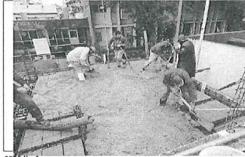
FOTO No. 2: DESCRIPCIÓN FOTOGRAFICA.- COLADO DE LOSA INSTALACION DE BARRO BLOCK Y ACERO DE REFUERZO. FOTOGRAFIA
