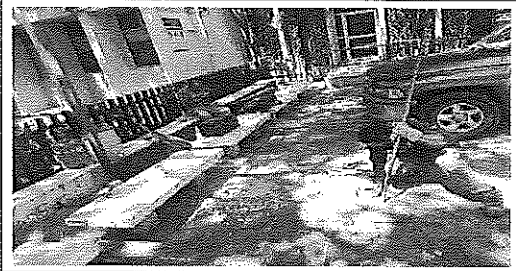
FOTO No. 1: DESCRIPCIÓN DE FOTOGRAFÍA- EXCAVACION PARA COLOCACION DE BARROTES 4X4 PARA TAPIAL. ESTA FOTOGRAFIA FUE TOMADA EL DIA- 21-09-2023.
