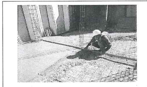
FOTO No. 4: DESCRIPCIÓN FOTOGRAFICA.- COLOCACION DE MALLA ELECTROSOLDADA. ESTA FOTOGRAFIA FUE TOMADA EL DIA 07-11-2023
