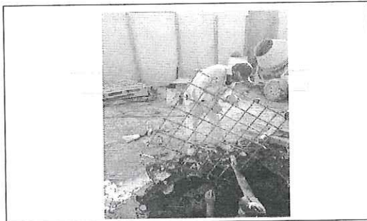
FOTO No. 4: DESCRIPCION FOTOGRAFICA.- COLOCACION DE PARRILLA DE ACERO DE REFUERZO EN ZAPATAS. ESTA FOTOGRAFIA FUE TOMADA EL DIA 13-10-2023
