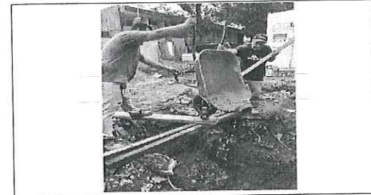
FOTO No. 3 DESCRIPCION DE FOTOGRAFIA.- COLADO DE CONCRETO EN ZAPATAS. FOTOGRAFIA TOMADA EL DIA 25-09-2023
