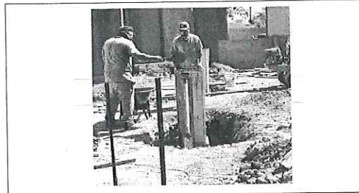
FOTO No. 2: DESCRIPCION FOTOGRAFICA.- COLADO DE CONCRETO EN PEDESTALES ESTA FOTOGRAFIA FUE TOMADA EL DIA 13-10-2023
