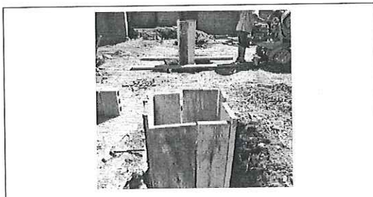
FOTO No. 7: DESCRIPCION FOTOGRAFICA.- COLOCACION DE CIMBRA EN CIMENTACION PARA PEDESTALES ESTA FOTOGRAFIA FUE TOMADA EL DIA 12-10-2023.
