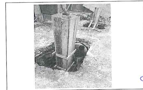
FOTO No. 6: DESCRIPCION FOTOGRAFICA.- COLADO DE CONCRETO EN PEDESTALES. ESTA FOTOGRAFIA FUE TOMADA EL DIA 13-10-2023
