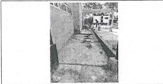
FOTO No. 1: COLADO DE BANQUETAS Y GUARNICIONES FOTOGRAFIA TOMADA EL DIA 31 DE DICIEMBRE 2023
