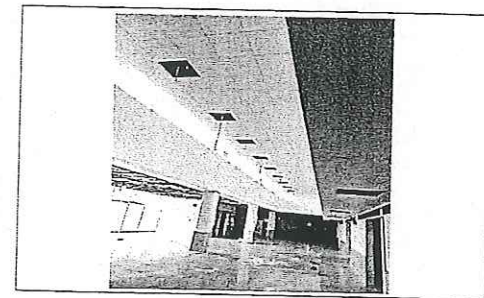
FOTO No. 9: PLAFON ESTRUCTURADO EN DOBLE ALTURA Y CANCELERIA DE ALUMINIO ESTA FOTOGRAFIA FUE TOMADA EL DIA 31 DE ENERO DE 2024
