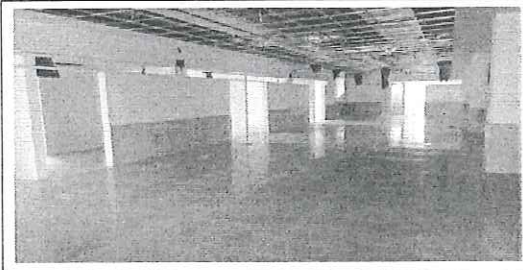
FOTO No. 1: CANCELERIA INTERIOR Y PLAFON ESTRUCTURADO EN SALA DE ESPERA FOTOGRAFIA TOMADA EL DIA 15 DE ENERO DE 2024.
