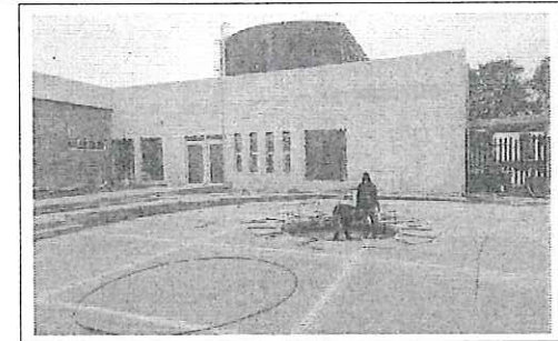
FOTO No. 6 CONSTRUCCION DE ARRIATE DE CONCRETO EN ACCESO PRINCIPAL ESTA FOTOGRAFIA FUE TOMADA EL DIA 15 DE ENERO DE 2024.
