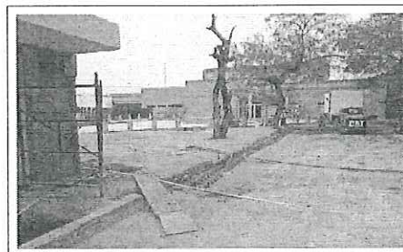
FOTO No. 8: TERRACERIAS EN VALIADIA DE OBRA EXTERIOR FOTOGRAFIA FUE TOMADA EL DIA 15 DE ENERO DE 2024.
