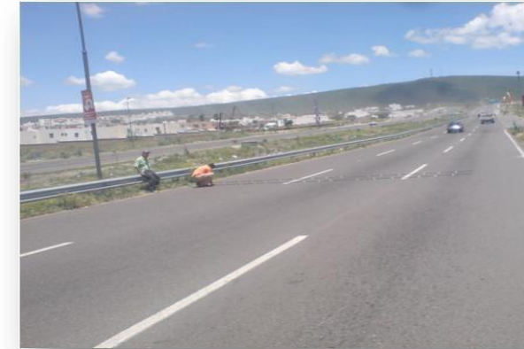
Figura 4. 37 Instalación de Equipos de Conteo Automático
