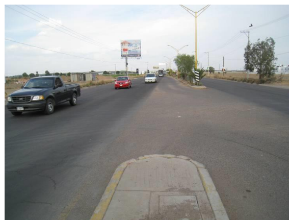
Vista de vías importantes de acceso al predio
