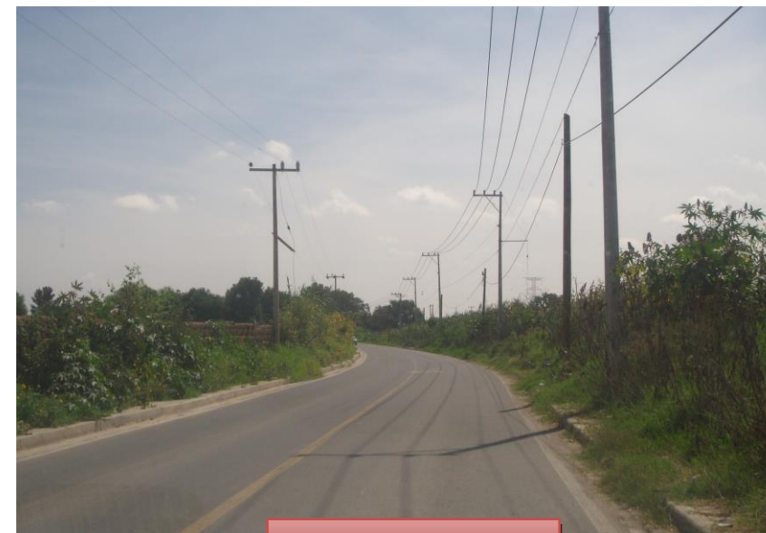
Vista del Camino Viejo a Tesitán
