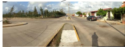
Vista Panorámica de la intersección, analizada.
