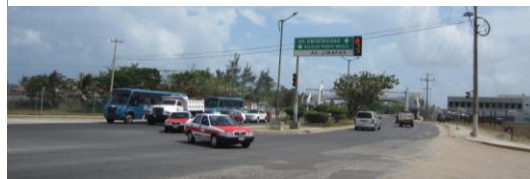
Vista Panorámica de la intersección, analizada.
