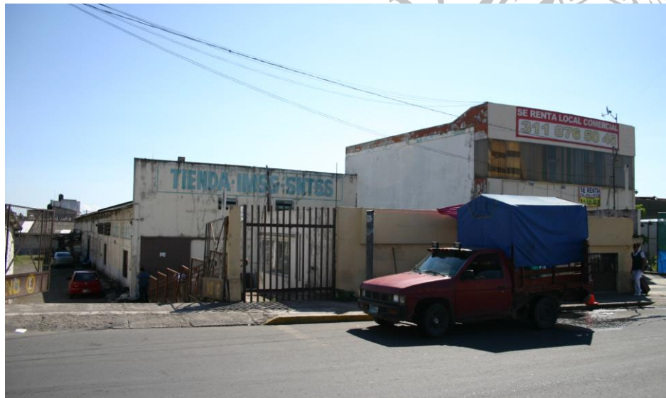
FOTOGRAFÍA 4.4. Vista frontal del predio sobre Avenida de los Insurgentes Poniente.
