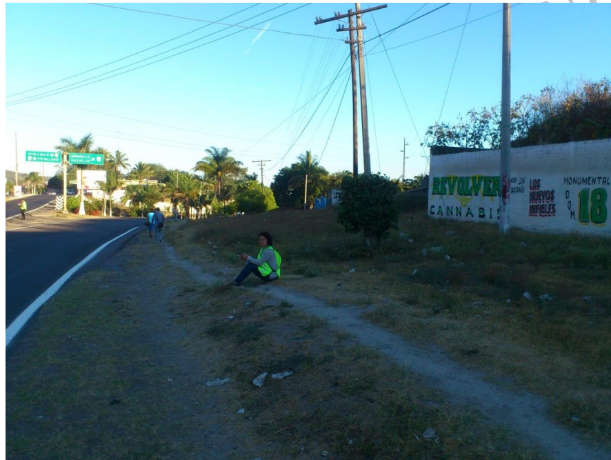
FIGURA 4.8. Línea eléctrica cercana al predio
