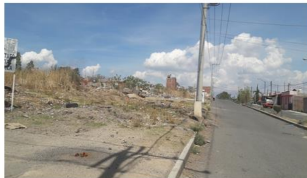
FOTOGRAFIA 03 Línea de media tensión y baja tensión que da servicio a la calle Asia, no existe alumbrado público al costado del predio.
