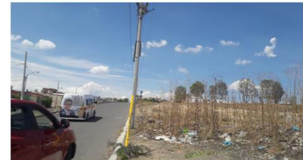
FOTOGRAFIA 04 Línea de media tensión y baja tensión que da servicio a la Av. México, no existe alumbrado público al costado del predio.
