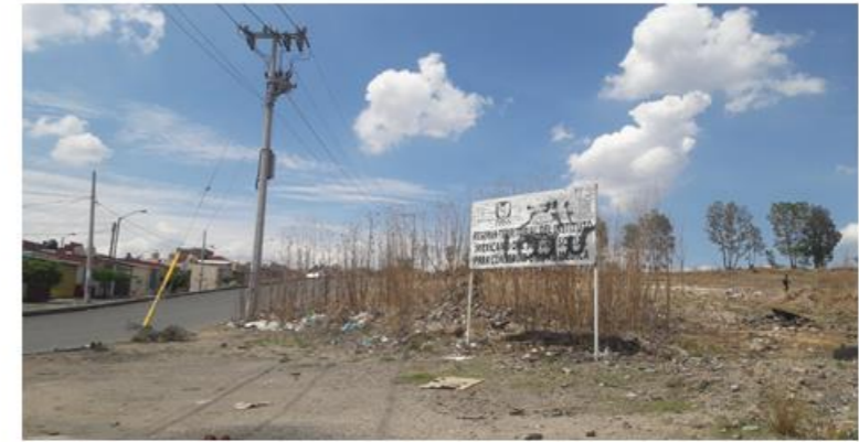
FOTOGRAFIA 02. Línea eléctrica y transformador sobre la Av. México.
