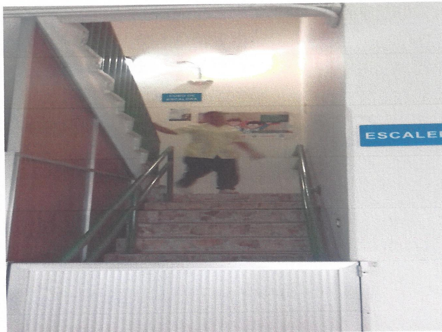
Cubo de Escalera
