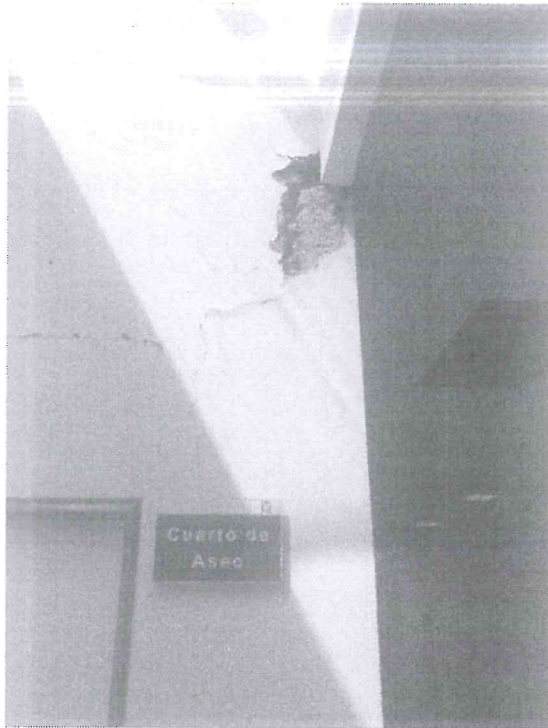
Figura 5, trabajos de albañilería que no ponen en riesgo la integridad estructural del inmueble
