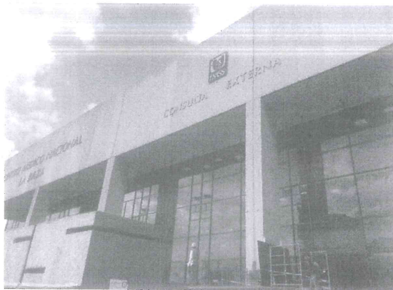
Figura 3, fachada integral del inmueble
