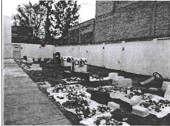
Estructura de la barda perimetral en buen estado
