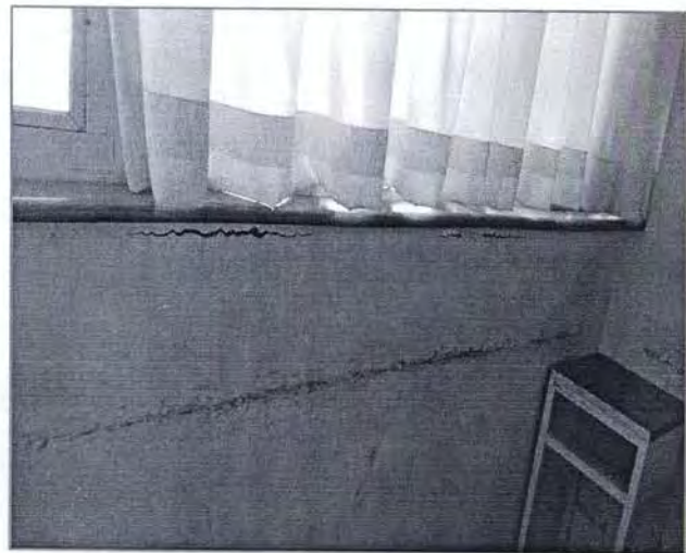
Fisuras en antepechos cerca del área de encamados de la torre de hospitalización del 2° al 5° nivel.
