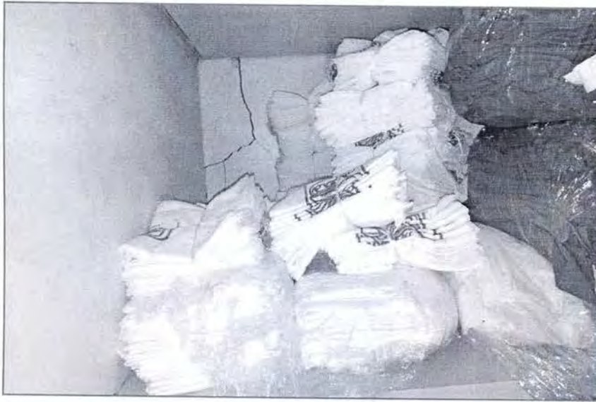
Grieta en muro del área de ropería en el sótano del edificio anexo a hospitalización.
