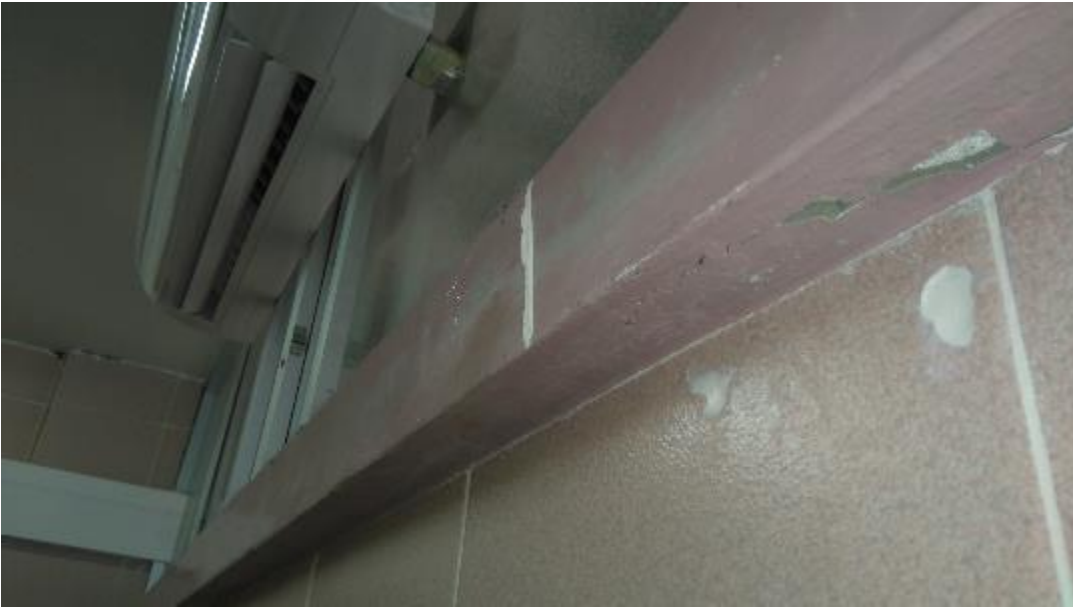
RECUBRIMIENTOS DESPRENDIDOS
