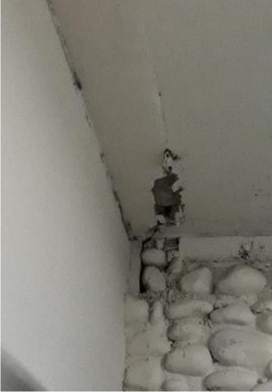
RECUBRIMIENTOS DESPRENDIDOS
