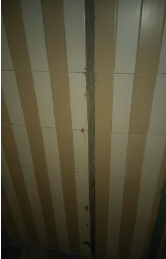
JUNTAS DE CONSTRUCCION EN MAL ESTADO
