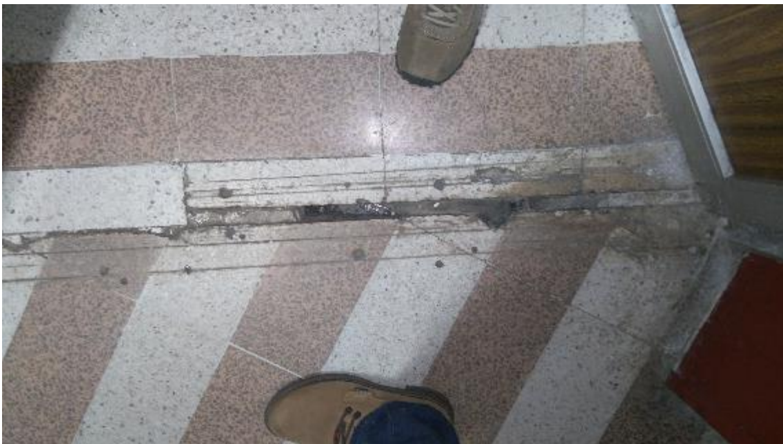
JUNTAS DE CONSTRUCCION EN MAL ESTADO
