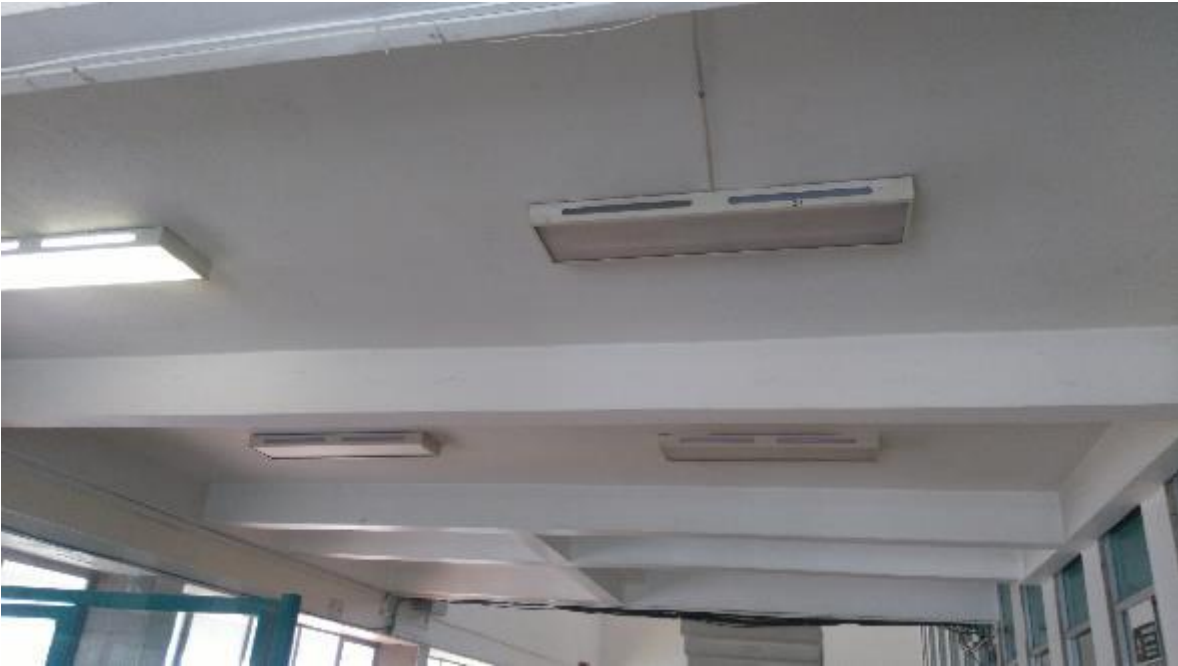
ELEMENTOS ESTRUCTURALES SIN DAÑO ALGUNO.
