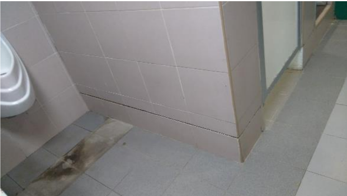
RECUBRIMIENTOS DESPRENDIDOS
