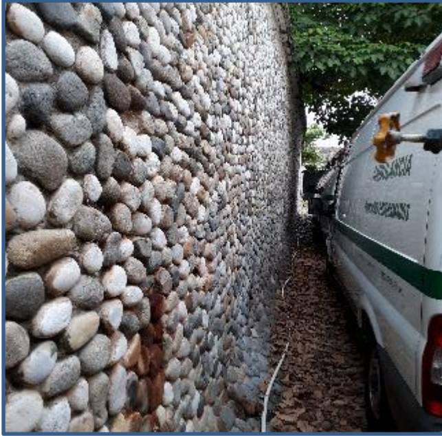
MURO DESPLOMADO EN ESTACIONAMIENTO NORTE
