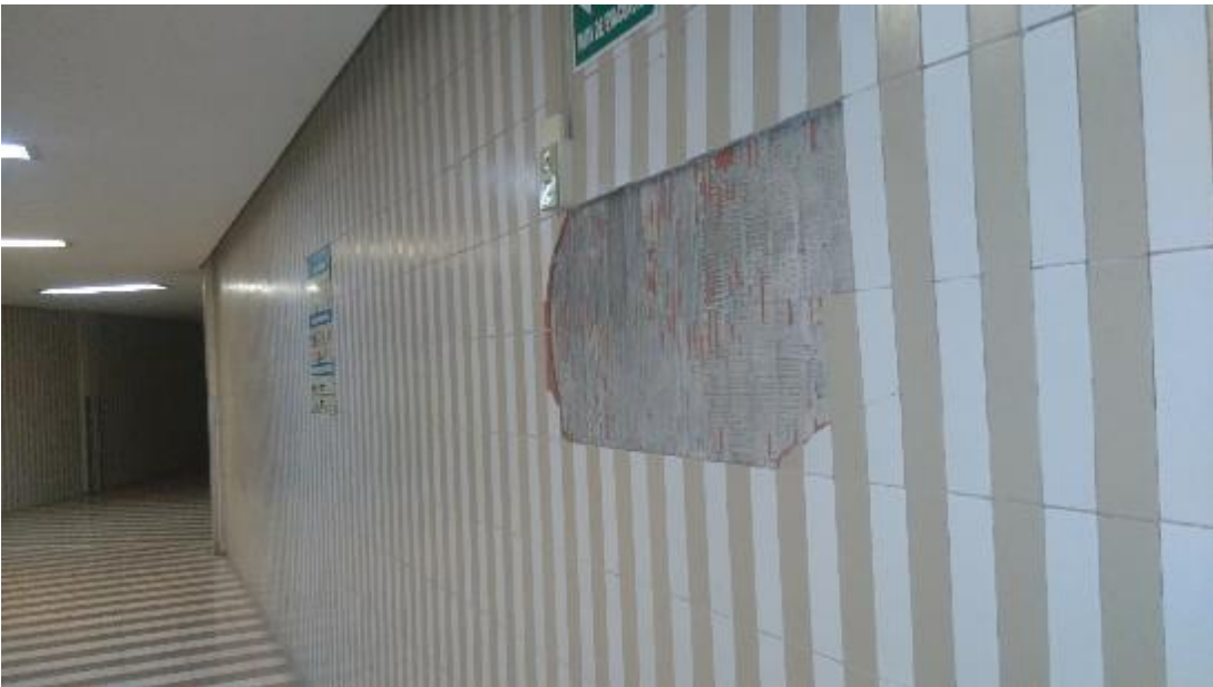
RECUBRIMIENTOS DESPRENDIDOS
