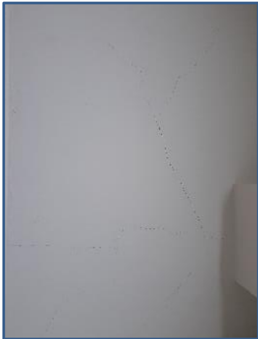
GRIETAS Y DESPRENDIMIENTO DE EMBOQUILLADOS
