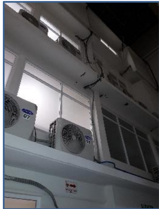
CUBO DE LUZ, CELOSIA EN BUEN ESTADO, Y SOLO LIGERAS GRIETAS EN ZONAS DE AIRES.
