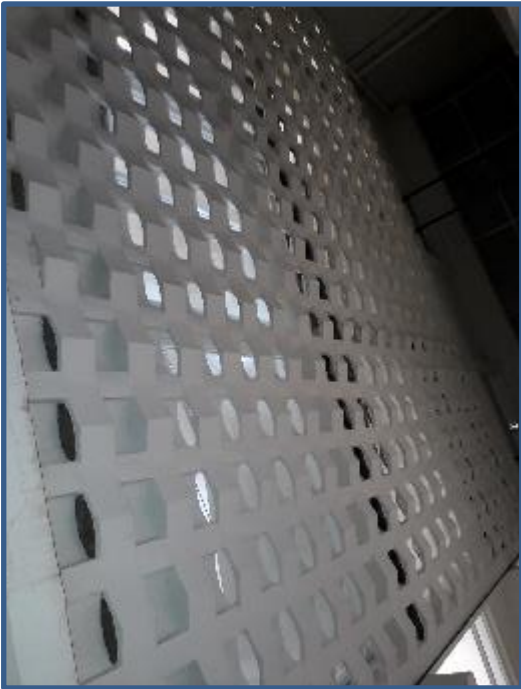
CUBO DE LUZ, CELOSIA EN BUEN ESTADO, Y SOLO LIGERAS GRIETAS EN ZONAS DE AIRES.
