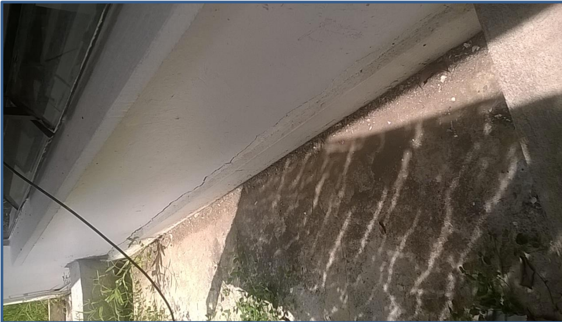
GRIETAS EN MUROS.
