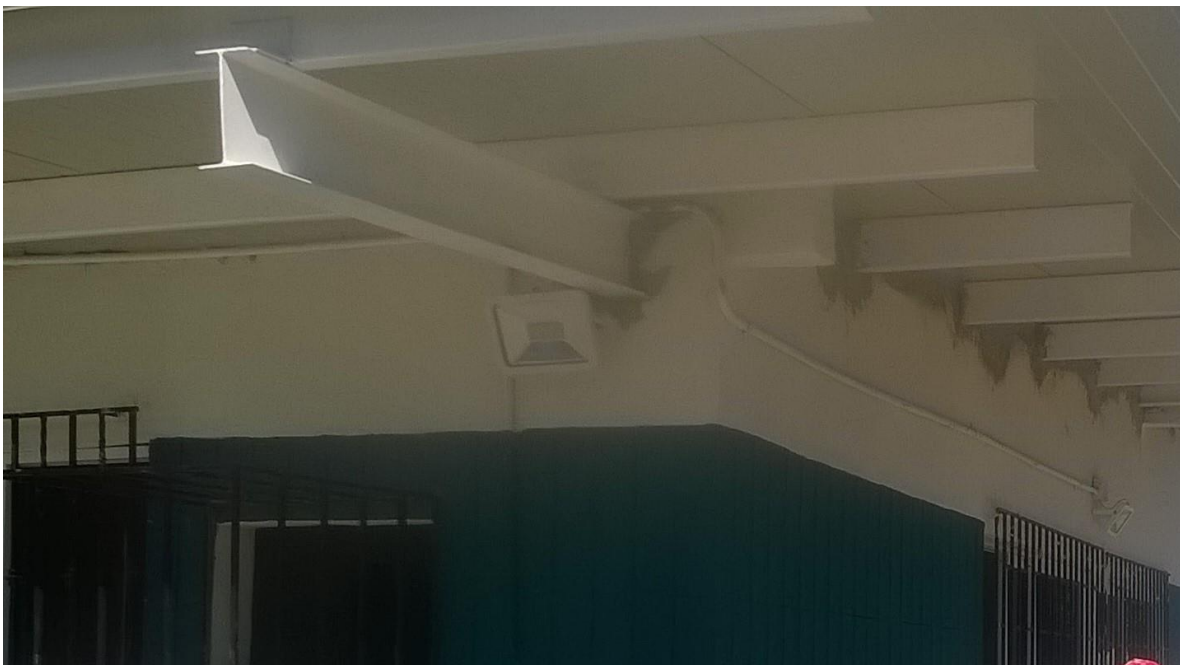
ESTRUCTURA Y LAMINA EN BUENAS CONDICIONES.
