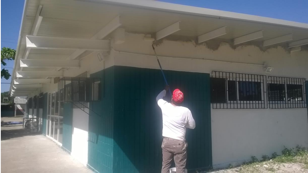
VISTA DE FACHADA.
