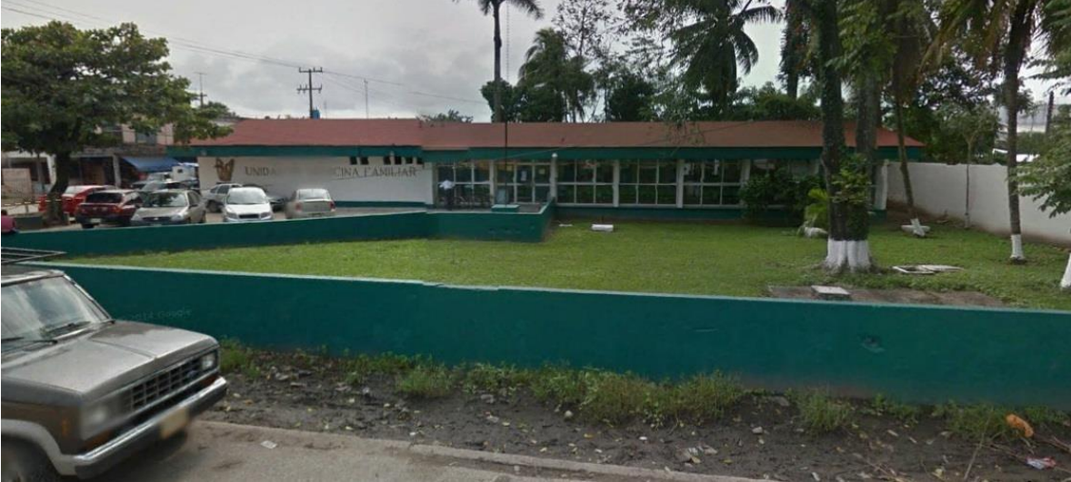
ESTRUCTRA DE CONCRETO CON COMPORTAMIENTO ADECUADO.
