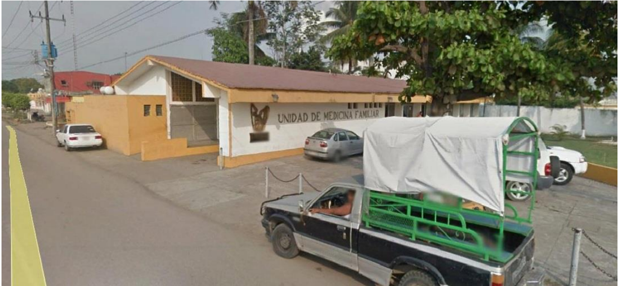
FACHADA EN BUEN ESTADO.
