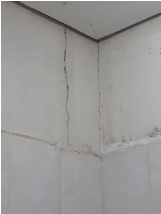
GRIETAS EN PLAFONES, JUNTAS Y MUROS NO ESTRUCTURALES
