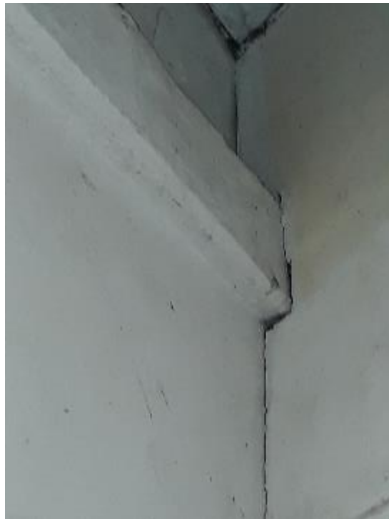
GRIETAS EN PLAFONES, JUNTAS Y MUROS NO ESTRUCTURALES
