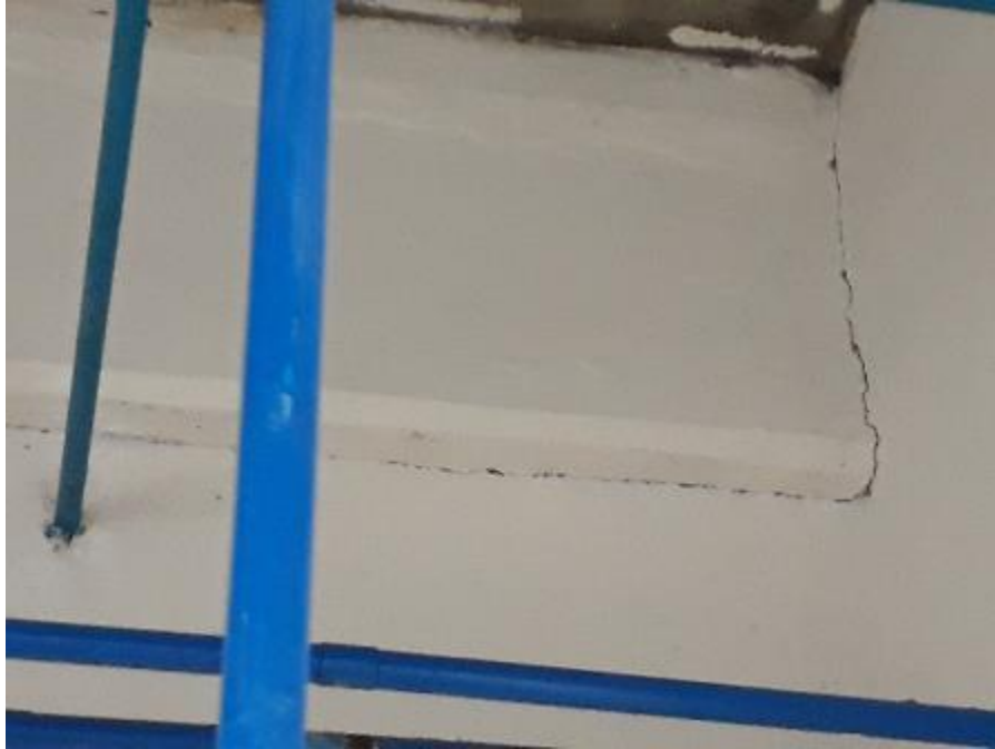
GRIETAS EN PLAFONES, JUNTAS Y MUROS NO ESTRUCTURALES
