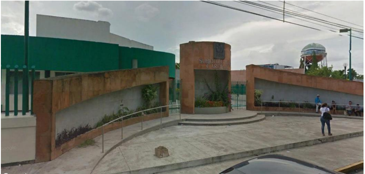
FACHADAS DEL INMUEBLE. ELEMENTOS EN BUEN ESTADO
