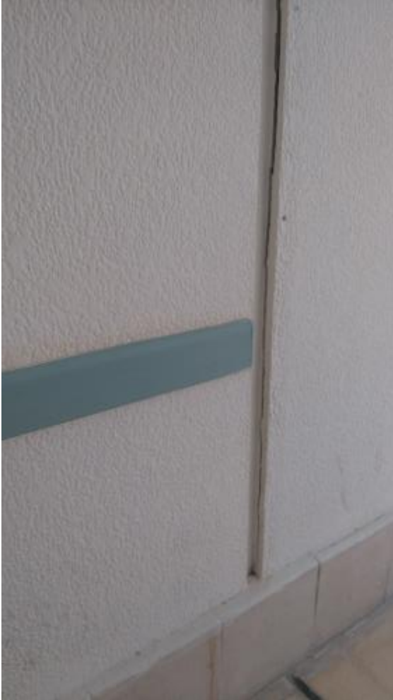
JUNTA DE CONSTRUCCION EN MUROS
