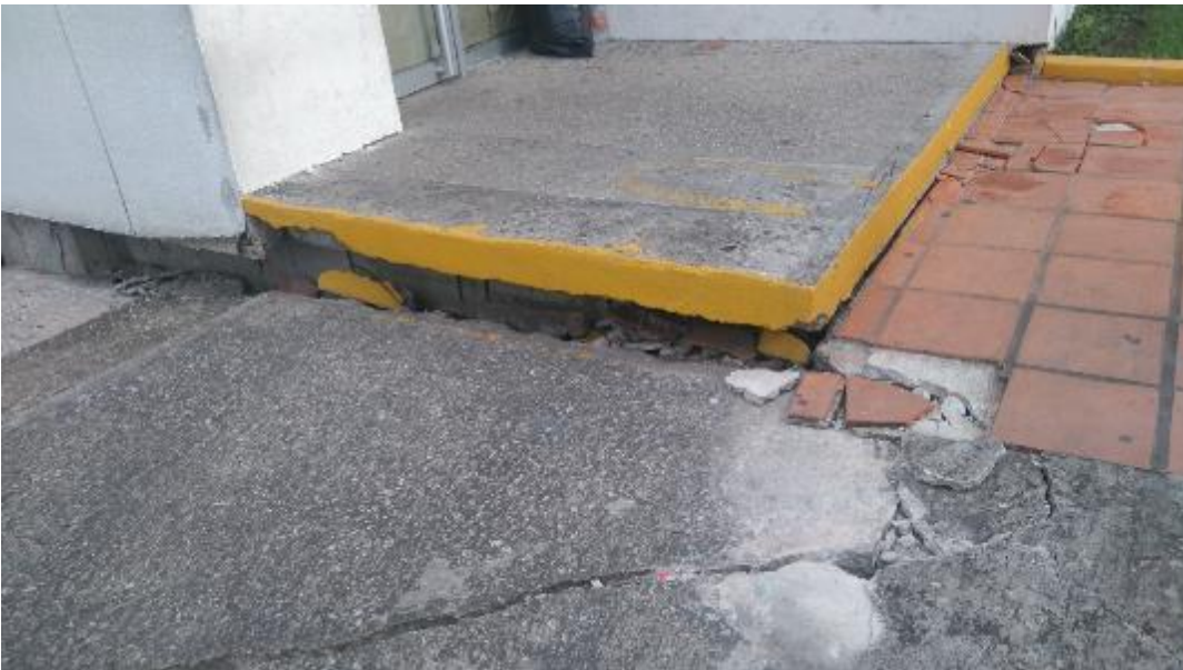
PISOS EXTERIORES MUY DETERIORADOS
