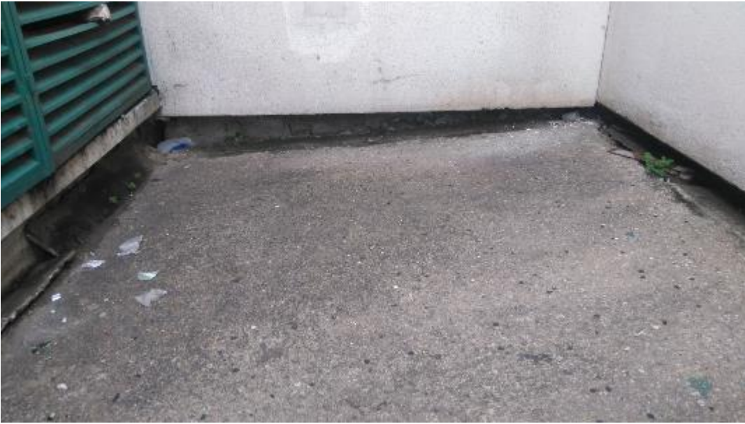
PISOS EXTERIORES MUY DETERIORADOS.
