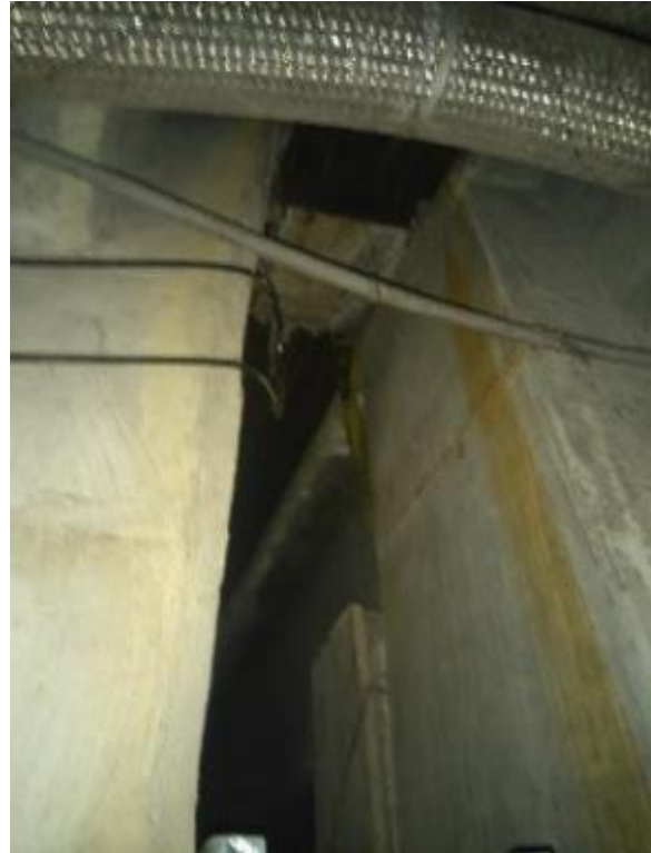
ELEMENTOS ESTRUCTURALES INTEGROS.
