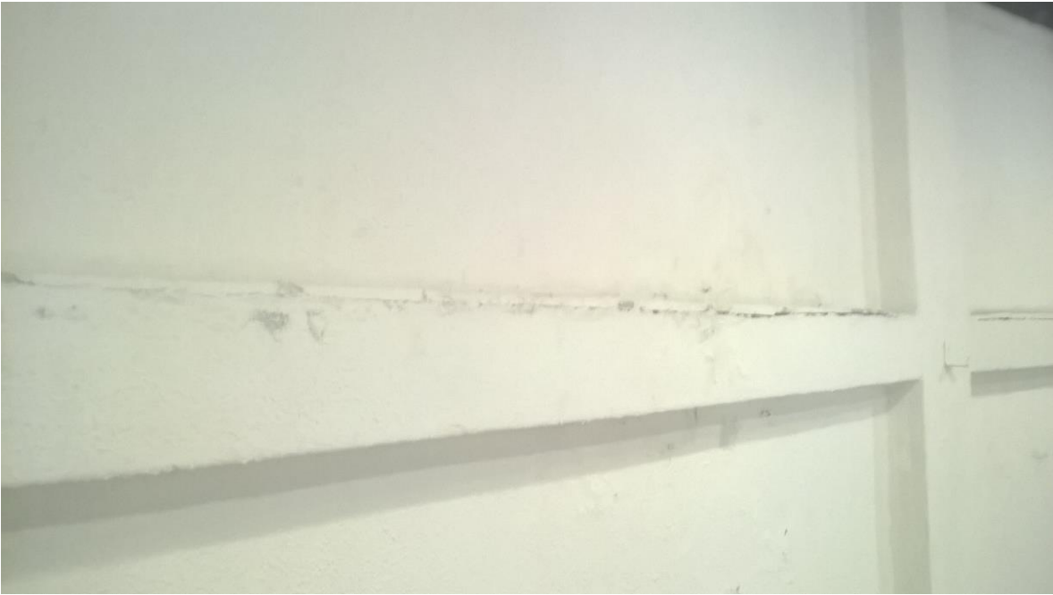
MURO DE CONTENCION SOTANO (DETERIORO DE ELEMENTOS NO ESTRUCTURALES).
