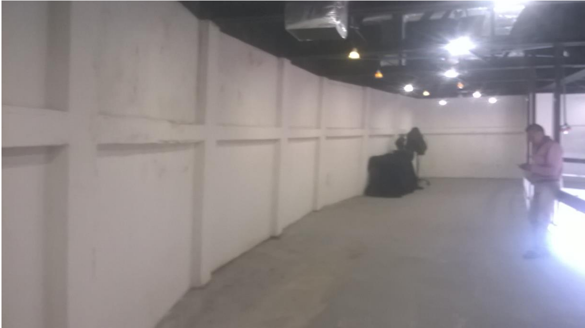
MURO DE CONTENCION EN SOTANO (EMBOQUILLADOS DESPRENDIDOS).
