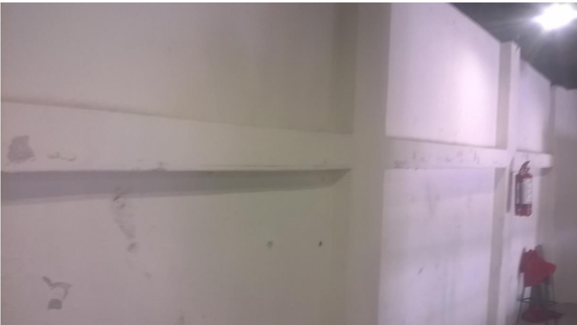
MURO DE CONTENCION SOTANO (DETERIORO DE ELEMENTOS NO ESTRUCTURALES).
