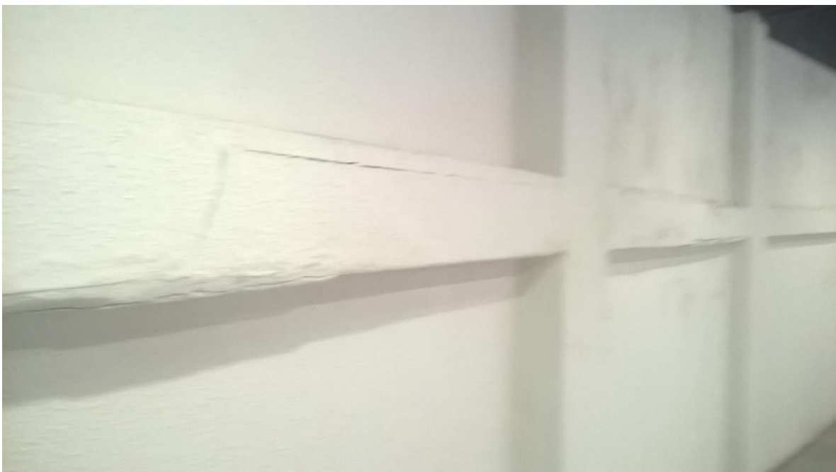
MURO DE CONTENCION EN SOTANO (EMBOQUILLADOS DESPRENDIDOS).
