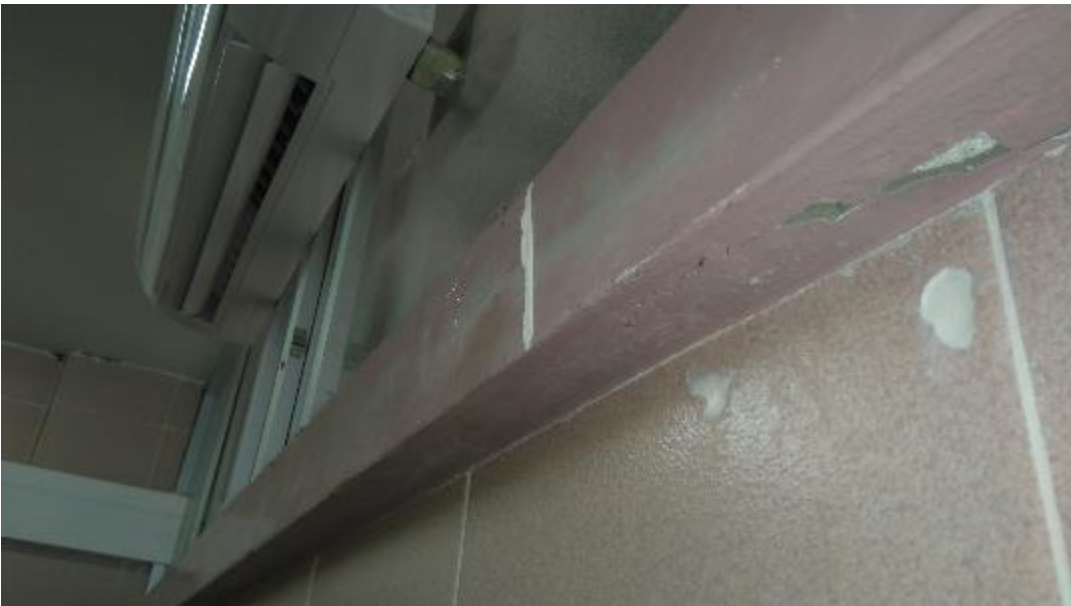
RECUBRIMIENTOS DESPRENDIDOS
