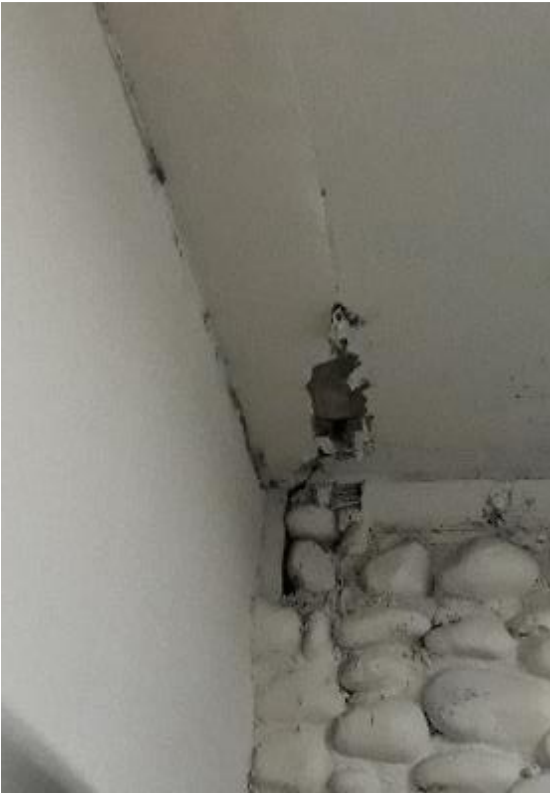
RECUBRIMIENTOS DESPRENDIDOS
