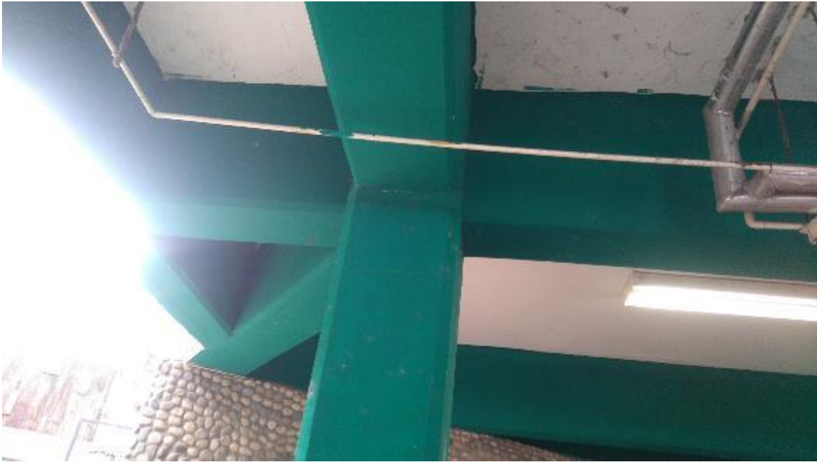
ELEMENTOS ESTRUCTURALES SIN DAÑO ALGUNO.
