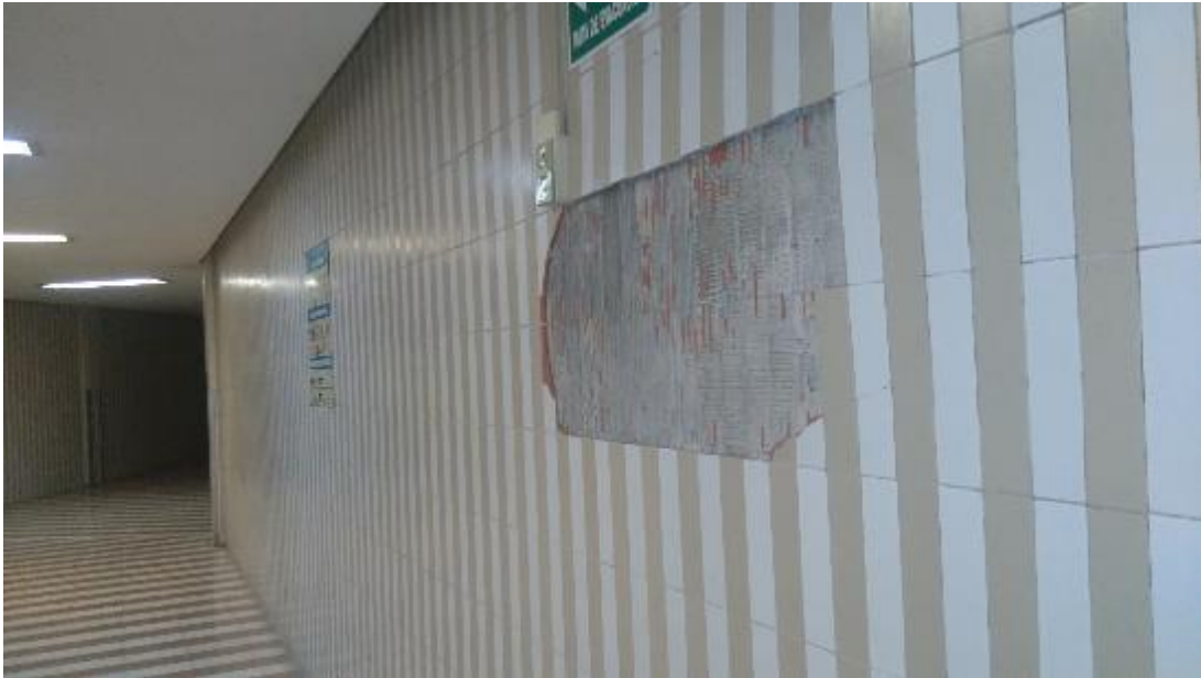
RECUBRIMIENTOS DESPRENDIDOS
