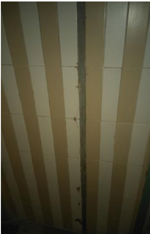
JUNTAS DE CONSTRUCCION EN MAL ESTADO
