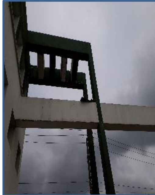
MARCO DE INGRESO, CON DESPRENDIMIENTO DE RECUBRIMIENTO.
