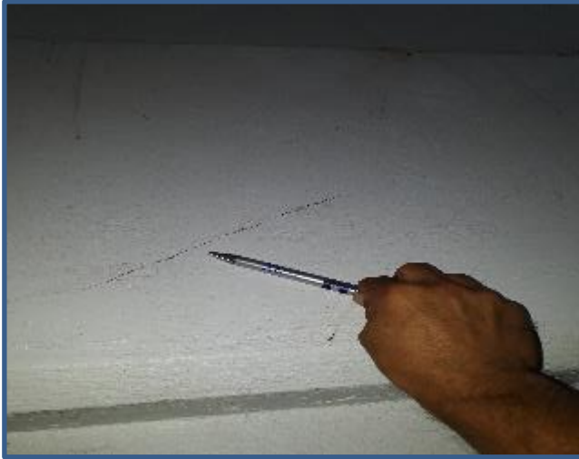
GRIETAS MINIMAS EN MUROS
