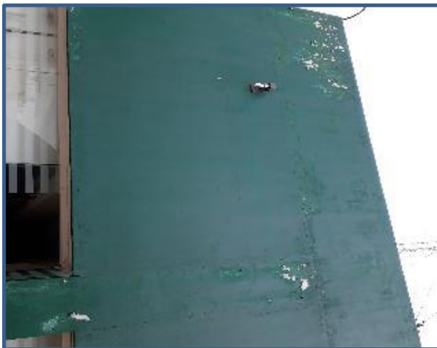
FACHADA CON VISIBLE DETERIORO POR LAS FILTRACIONES DE AGUA.
