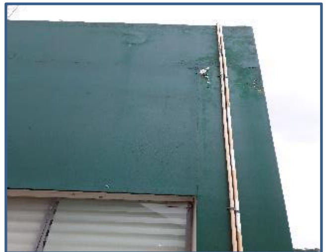
FACHADA CON VISIBLE DETERIORO POR LAS FILTRACIONES DE AGUA.
