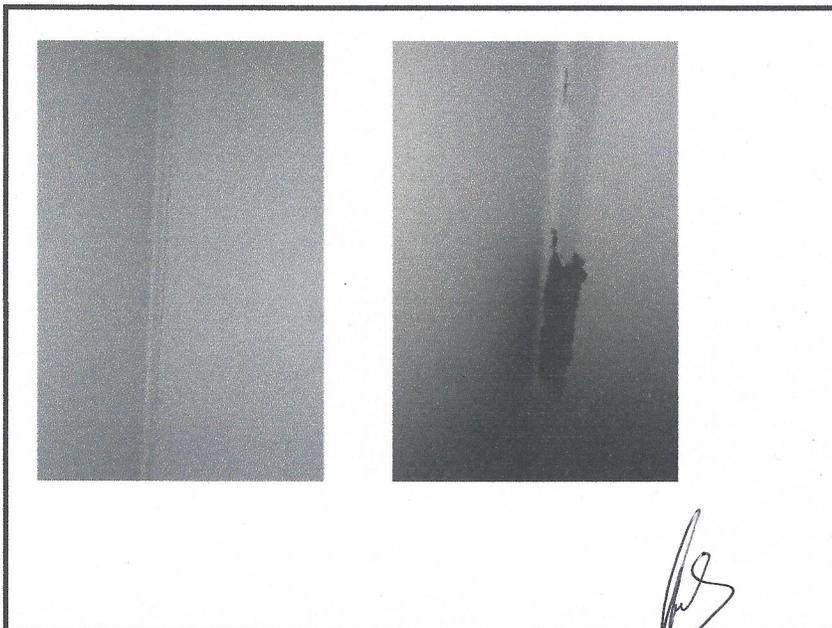
DESCRIPCION:SE OBSERVA QUE SE DESPEGO EL MURO DEL CASTILLO PERO LAS LOSAS CON LOS CASTILLOS NO SUFREN FRACTURA POR LO CUAL NO HAY
