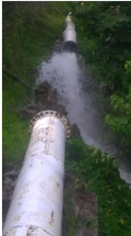
Colapso de red hidráulica de abastecimiento
