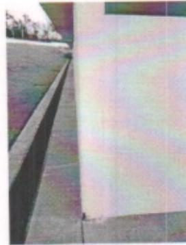
DETALLE DE DAÑOS EN JUNTAS FRIAS EN MUROS CON TRABES, HORIZONTALES CON UNA SEPARACION PROMEDIO DE 1.80mm. QUE SON GRIETAS HORIZONTALES EN CORONA, FALLA DE TENSION DIAGONAL EN VIGAS DE ACOPLAMIENTO EN MUROS DE CORTANTE
