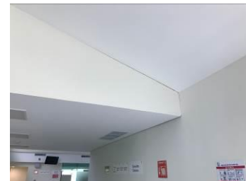
CONSULTORIO TIPO Y DETALLE DE PLAFONES CON DESPRENDIMIENTO DE UNION POR JUNTA FRIA POR SISMO
