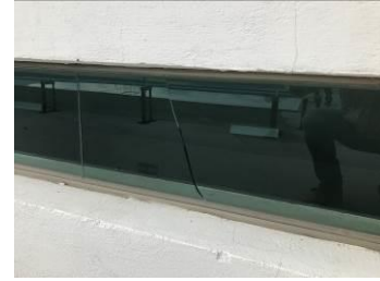
ROTURA DE CRISTALES PORASENTAMIENTOS DIFERENCIALES POR SISMO, VISTA GENERAL DE ESTRUCTURACION Y CRISTALES ROTOS POR TORSION DE ESTRUCTURA EN MARCOS DE CARGA
