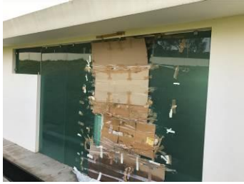
ROTURA DE CRISTALES PORASENTAMIENTOS DIFERENCIALES POR SISMO, VISTA GENERAL DE ESTRUCTURACION Y CRISTALES ROTOS POR TORSION DE ESTRUCTURA EN MARCOS DE CARGA
