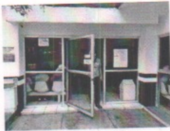
ASENTAMIENTOS DIFERENCIALES POR FUERZAS DE CORTANTES EN PUERTAS DE ACCESO Y VENTANAS POR FLEXOCOMPRESION DE TRABE OCASIONADOS POR EL SISMO
