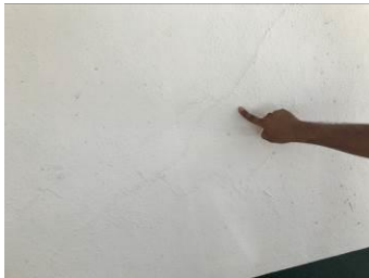
DAÑOS EN JUNTAS FRIAS EN MUROS CON TRABES, HORIZONTALES CON UNA SEPARACION PROMEDIO DE 1.80mm. QUE SON GRIETAS HORIZONTALES EN CORONA, FALLA DE TENSION DIAGONAL EN VIGAS DE ACOPLAMIENTO EN MUROS DE CORTANTE Y ASENTAMIENTOS DIFERENCIALES POR FUERZAS DE CORTANTES OCASIONADOS POR EL SISMO
