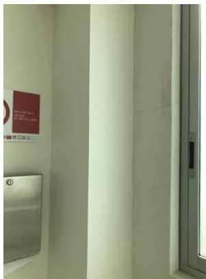
DETALLE DE FISURA POR ADHERENCIA EN MARCO DE VENTANA Y VISTA GENERAL CONSULTORIO TIPO
