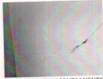
FALLA DE TENSION DIAGONAL EN VIGAS DE ACOPLAMIENTO EN MUROS DE CORTANTE Y ASENTAMIENTOS DIFERENCIALES POR FUERZAS DE CORTANTES OCASIONADOS POR EL SISMO
