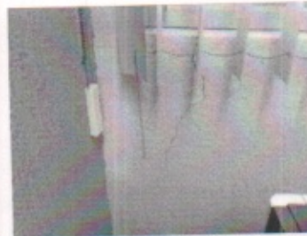
FALLA DE TENSION DIAGONAL EN VIGAS DE ACOPLAMIENTO EN MUROS DE CORTANTE Y ASENTAMIENTOS DIFERENCIALES POR FUERZAS DE CORTANTES OCASIONADOS POR EL SISMO VISTA GENERAL EN CONSULTORIO DE MEDICINA GENERAL
