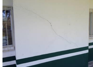
DAÑOS EN JUNTAS FRIAS EN MUROS CON COLUMNAS, VERTICALES CON UNA SEPARACION PROMEDIO DE 3.00mm A 25.00mm. FALLA DE TENSION DIAGONAL EN VIGAS DE ACOPLAMIENTO EN MUROS DE CORTANTE Y ASENTAMIENTOS DIFERENCIALES POR FUERZAS DE CORTANTES OCASIONADOS POR EL SISMO, EN DIFERENTES AREAS DE LA UNIDAD MEDICA.
