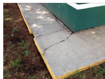
BANQUETA PERIMETRAL HUNDIMIENTOS POR ASENTAMIENTOS DIFERENCIALES POR FUERZAS DE CORTANTES OCASIONADOS POR EL SISMO
