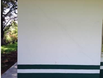
DAÑOS EN JUNTAS FRIAS EN MUROS CON COLUMNAS, VERTICALES CON UNA SEPARACION PROMEDIO DE 3.00mm A 25.00mm. FALLA DE TENSION DIAGONAL EN VIGAS DE ACOPLAMIENTO EN MUROS DE CORTANTE Y ASENTAMIENTOS DIFERENCIALES POR FUERZAS DE CORTANTES OCASIONADOS POR EL SISMO, EN DIFERENTES AREAS DE LA UNIDAD MEDICA.
