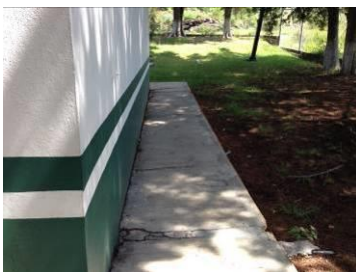
BANQUETA PERIMETRAL HUNDIMIENTOS POR ASENTAMIENTOS DIFERENCIALES POR FUERZAS DE CORTANTES OCASIONADOS POR EL SISMO
