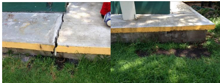
ASENTAMIENTOS DIFERENCIALES POR FUERZAS DE CORTANTES OCASIONADOS POR EL SISMO
