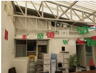
SANITARIO PERSONAL IMSS, DETALLE DE ARMADO DE ACERO EN CUBO DE LUZ Y VESTIBULO CON PASILLOS DE DISTRIBUCION GENERAL PLANTA BAJA
