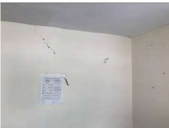
FALLA DE TENSION DIAGONAL EN VIGAS DE ACOPLAMIENTO EN MUROS DE CORTANTE Y ASENTAMIENTOS DIFERENCIALES POR FUERZAS DE CORTANTES OCASIONADOS POR EL SISMO, EN AREAS ADMINISTRATIVAS PLANTA ALTA
