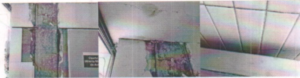
DETALLE DE ESTRUCTURACION GENERAL DE VESTIBULO DE DISTRIBUCION PRINCIPAL Y MURO CON FISURA DE JUNTA FRIA
