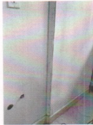
DETALLE DE ESTRUCTURACION GENERAL DE VESTIBULO DE DISTRIBUCION PRINCIPAL Y MURO CON FISURA DE JUNTA FRIA
