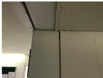
DETALLE DE JUNTA COSNTRUCTIVA EN PASILLO DE LACTARIO AL ORIENTE Y PASILLO DE GINECOLOGIA AL PONIENTE PRIMER NIVEL
