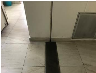
DETALLE DE JUNTA COSNTRUCTIVA EN PASILLO DE LACTARIO AL ORIENTE Y PASILLO DE GINECOLOGIA AL PONIENTE PRIMER NIVEL
