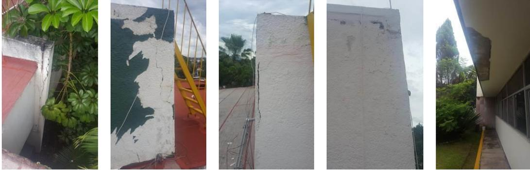
DAÑOS EN JUNTAS FRIAS EN MUROS CON COLUMNAS, VERTICALES DE FALLA DE TENSION DIAGONAL EN VIGAS DE ACOPLAMIENTO EN MUROS DE CORTANTE, DAÑOS EN JUNTAS FRIAS EN MUROS CON TRABES, HORIZONTALES, QUE SON GRIETAS HORIZONTALES EN CORONA Y ASENTAMIENTOS DIFERENCIALES POR FUERZAS DE CORTANTES OCASIONADOS POR EL SISMO, EN DIFERENTES AREAS DEL HOSPITAL.
