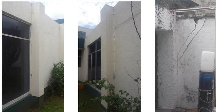
DAÑOS EN JUNTAS FRIAS EN MUROS CON COLUMNAS, VERTICALES DE FALLA DE TENSION DIAGONAL EN VIGAS DE ACOPLAMIENTO EN MUROS DE CORTANTE, DAÑOS EN JUNTAS FRIAS EN MUROS CON TRABES, HORIZONTALES, QUE SON GRIETAS HORIZONTALES EN CORONA Y ASENTAMIENTOS DIFERENCIALES POR FUERZAS DE CORTANTES OCASIONADOS POR EL SISMO, EN DIFERENTES AREAS DEL HOSPITAL.
