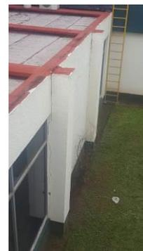
DAÑOS EN JUNTAS FRIAS EN MUROS CON COLUMNAS, VERTICALES DE FALLA DE TENSION DIAGONAL EN VIGAS DE ACOPLAMIENTO EN MUROS DE CORTANTE, DAÑOS EN JUNTAS FRIAS EN MUROS CON TRABES, HORIZONTALES, QUE SON GRIETAS HORIZONTALES EN CORONA Y ASENTAMIENTOS DIFERENCIALES POR FUERZAS DE CORTANTES OCASIONADOS POR EL SISMO, EN DIFERENTES AREAS DEL HOSPITAL.
