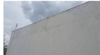
DAÑOS EN JUNTAS FRIAS EN MUROS CON TRABES, HORIZONTALES, QUE SON GRIETAS HORIZONTALES EN CORONA Y ASENTAMIENTOS DIFERENCIALES POR FUERZAS DE CORTANTES OCASIONADOS POR EL SISMO, EN DIFERENTES AREAS DEL HOSPITAL.
