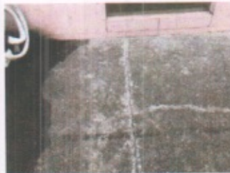
CONTINUACION DE GRIETA FALLA DE TENSION DIAGONAL EN VIGAS DE ACOPLAMIENTO EN MUROS DE CORTANTE Y ASENTAMIENTOS DIFERENCIALES POR FUERZAS DE CORTANTES OCASIONADOS POR EL SISMO
