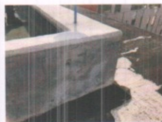
FALLA DE TENSION DIAGONAL EN VIGAS DE ACOPLAMIENTO EN MUROS DE CORTANTE EN CORONA Y ASENTAMIENTOS DIFERENCIALES POR FUERZAS DE CORTANTES OCASIONADOS POR EL SISMO
