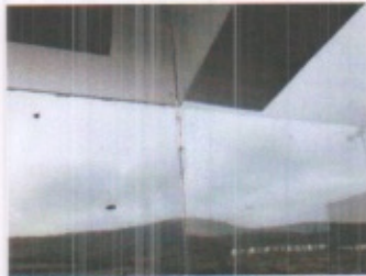
FALLA DE TENSION DIAGONAL EN VIGAS DE ACOPLAMIENTO EN MUROS DE CORTANTE EN CORONA Y ASENTAMIENTOS DIFERENCIALES POR FUERZAS DE CORTANTES OCASIONADOS POR EL SISMO
