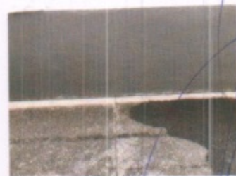
CONTINUACION DE GRIETA FALLA DE TENSION DIAGONAL EN VIGAS DE ACOPLAMIENTO EN MUROS DE CORTANTE Y ASENTAMIENTOS DIFERENCIALES POR FUERZAS DE CORTANTES OCASIONADOS POR EL SISMO
