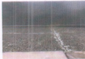
FALLA DE TENSION DIAGONAL EN VIGAS DE ACOPLAMIENTO EN MUROS DE CORTANTE Y ASENTAMIENTOS DIFERENCIALES POR FUERZAS DE CORTANTES EN PISO OCASIONADOS POR EL SISMO EN AREA DE LABORATORIOS
